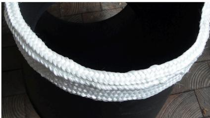
Abb. 8: Dichtung um Rauchrohr
