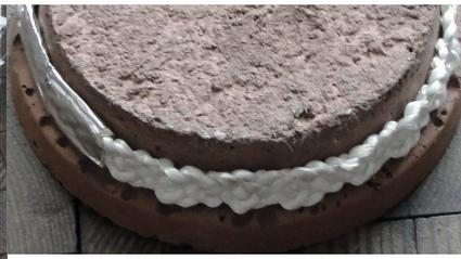
Abb. 9: Dichtung um Putzdeckel
