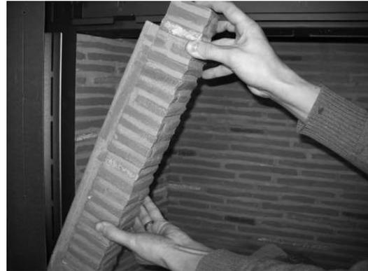
3. Entfernen Sie die linke und rechte vertikale Klinkerblende, indem Sie diese an der Oberseite ergreifen, nach innen kippen und wegnehmen.
